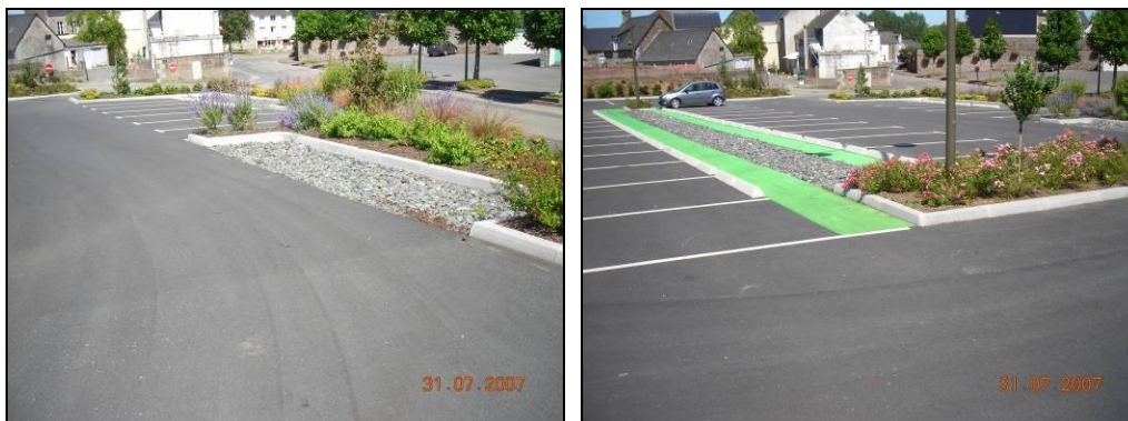
Photo 4 : Exemple de tranchées drainantes
